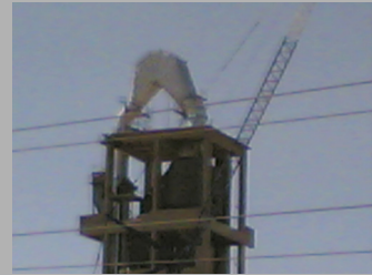
Ön Isıtıcı Gaz Kanalları
