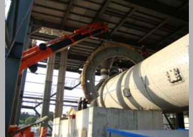
Fener Dişli Montajı (2x14 ton)
