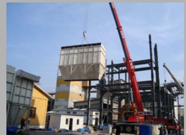
60000m 3 /h Filtre Montajı
