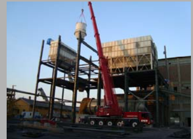
Katkı Silosu Montajı (9 ton)
